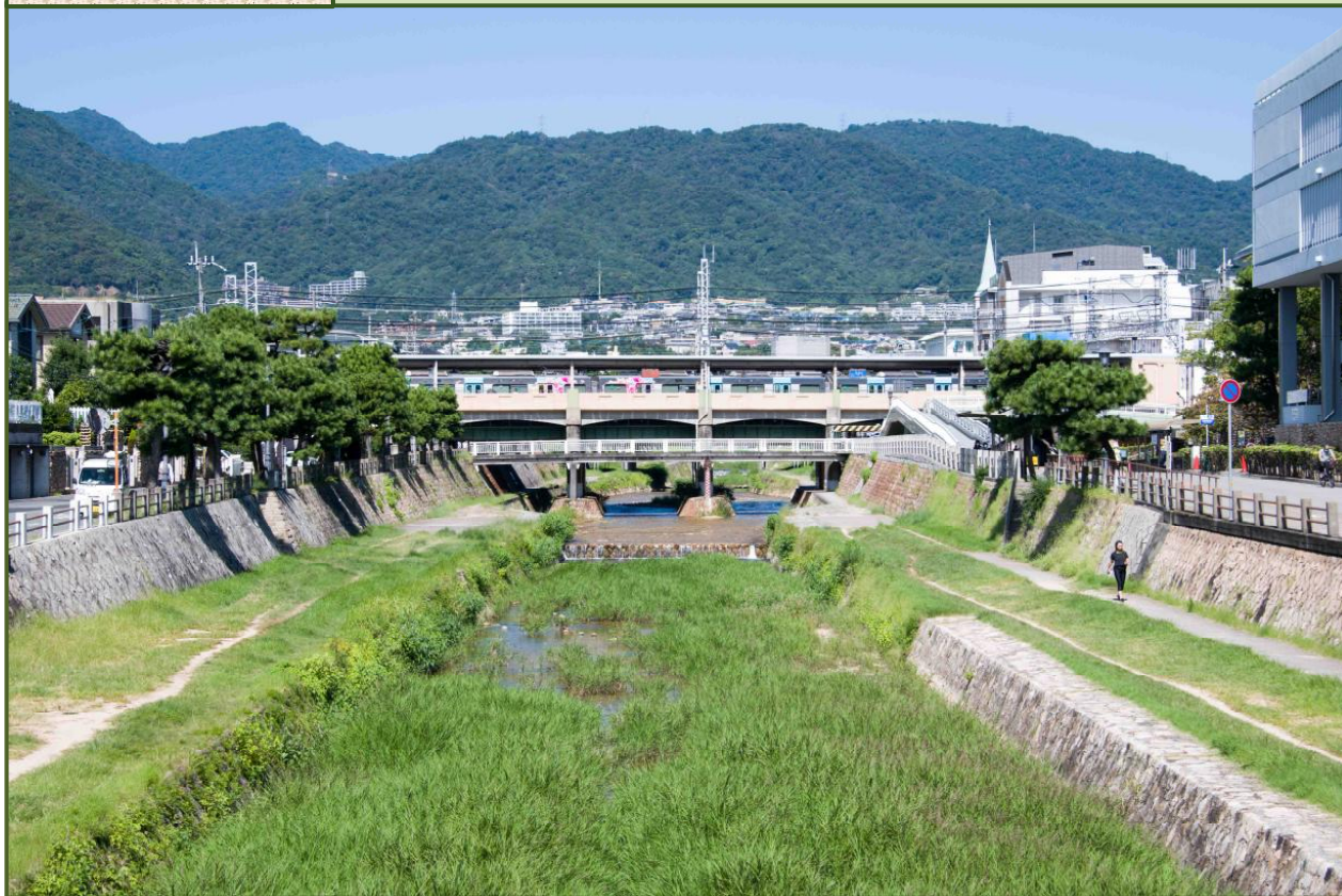
写真-1 国道43号・芦屋川橋から上流方向を撮影（令和3年9月）
