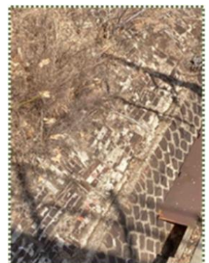
写真-18 解体したレンガ壁 を利用した法面工
