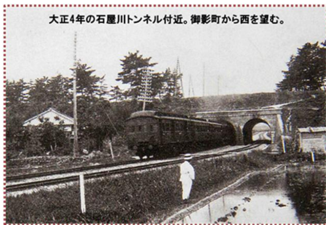
写真-7 複線化後の石屋川隧道 (『写真集 神戸 100 年』から引用・加工)
