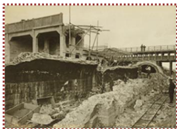
写真-9 複々線化のため大正8年12月 石屋川隧道を解体（隧道下部は翠帳の石積み） (旧石屋川隧道記念碑の写真を引用)
