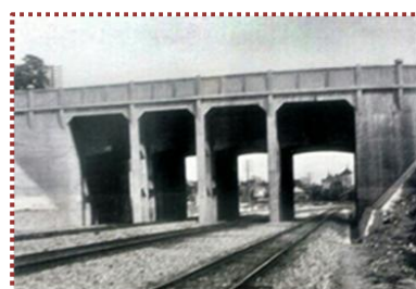
写真-11 複々線化とその上に架けられた水 路橋完成当初は3線、後に4線になる。 (旧石屋川隧道記念碑の写真を引用)
