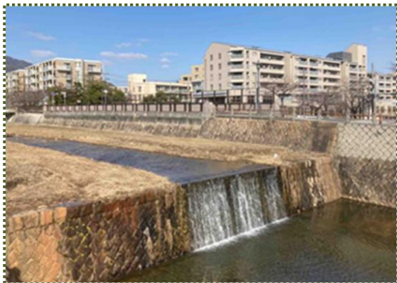
写真-16 芦屋川右岸道路から左岸方向を撮影
