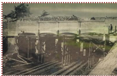
写真-10 跨線水路橋新設のための仮水路 を支える足場を撤去している (旧石屋川隧道記念碑の写真を引用)
