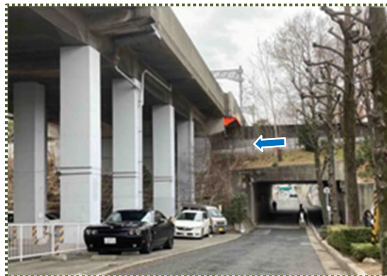
写真-13 東海道本線高架下を流れる石屋川
