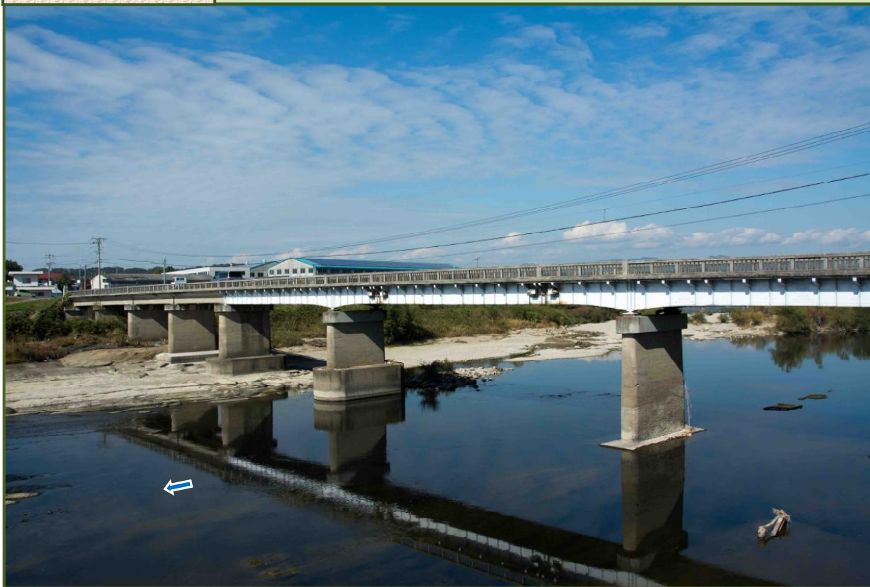
写真-1 加古川に架かる大門橋（平成 27 年 11 月撮影）
