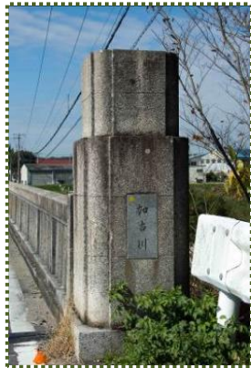
写真-11 左岸上流側親柱 「加古川」
