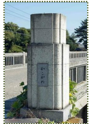
写真-13 右岸下流側親柱 「かこがわ」
