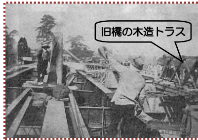
写真-7 三代目大門橋の作業風景(昭和10年) 『大門誌』から引用・加工
