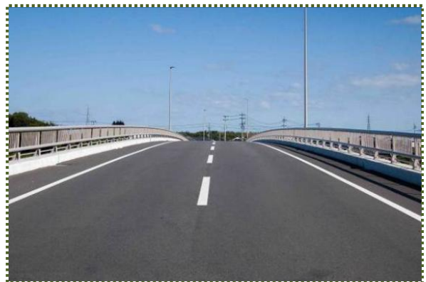
写真-19 四代目大門橋（令和 7 年 10 月撮影）
