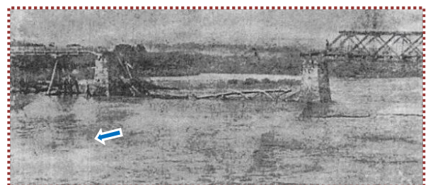
写真-6 二代目大門橋腐朽のため落下（昭和 4 年） （『大門誌』から引用・加工）
