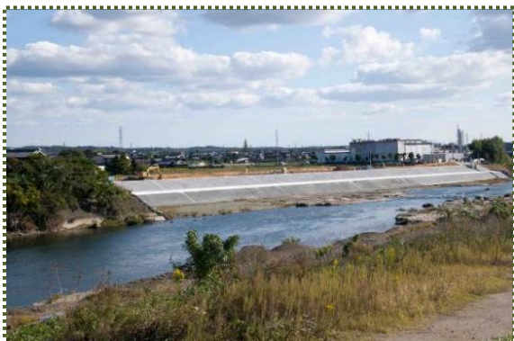
写真-16 大門橋から下流左岸部を撮影（令和4年10月）
