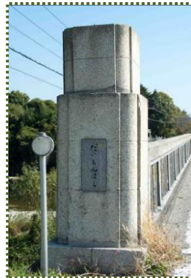
写真-12 右岸上流側親柱 「だいもんはし」
