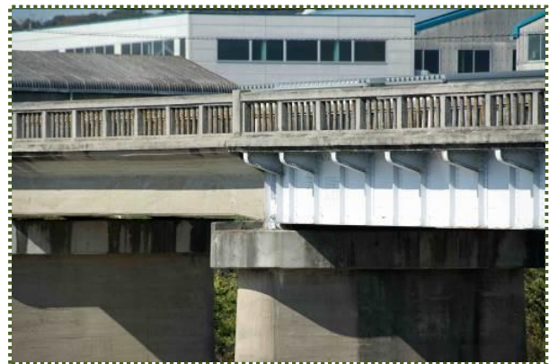
写真-9 中央の橋脚より左が RCT 桁、右が鉸桁
