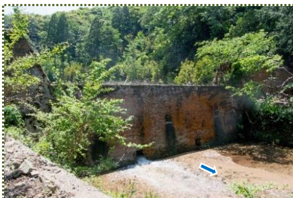
写真-6 岩手堰堤 (令和 5 年 5 月撮影)
