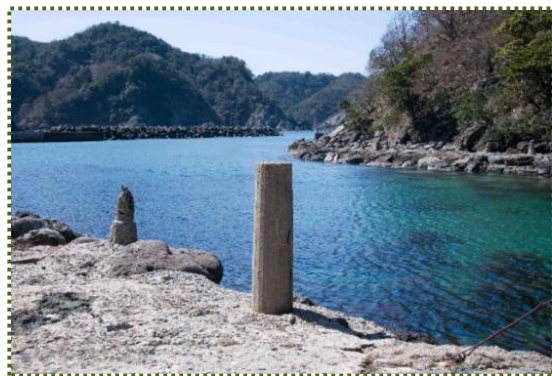
写真-2 亀山側の導流堤から不動山側を撮影
