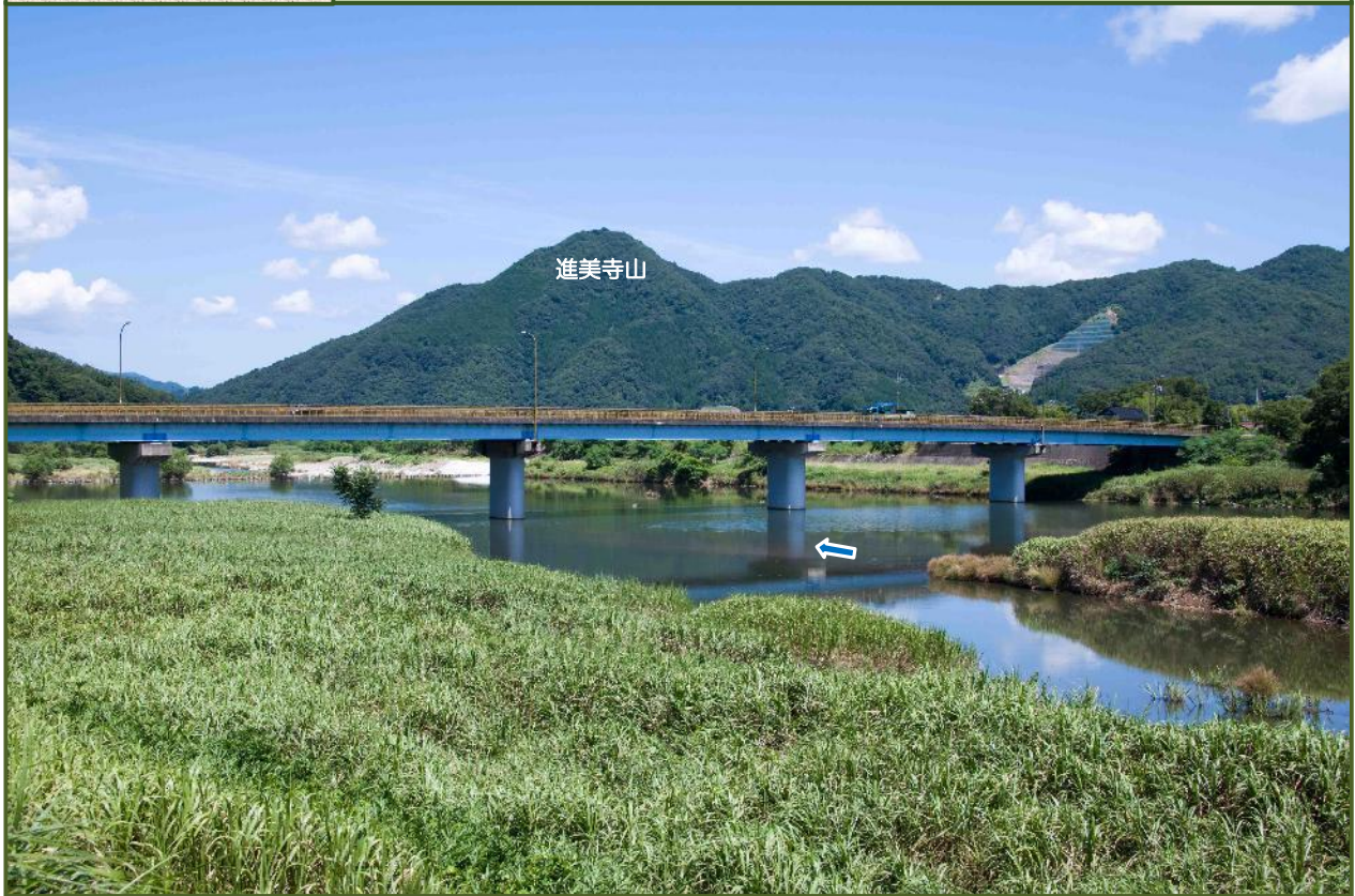
写真-1 円山川と伊佐橋（令和3年8月撮影）
