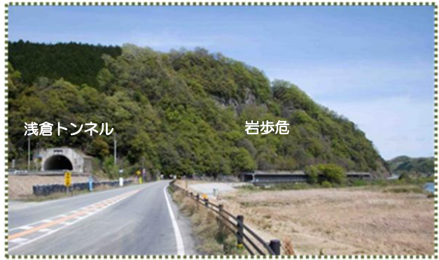
写真-7 国道312号から岩歩危および浅倉トンネルを撮影
