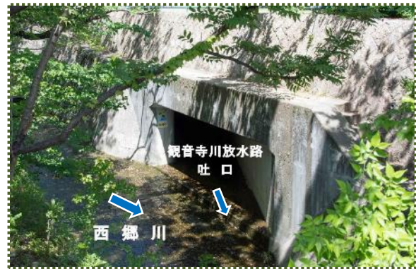
写真-7 観音寺川放水路吐口（天城橋から撮影）
