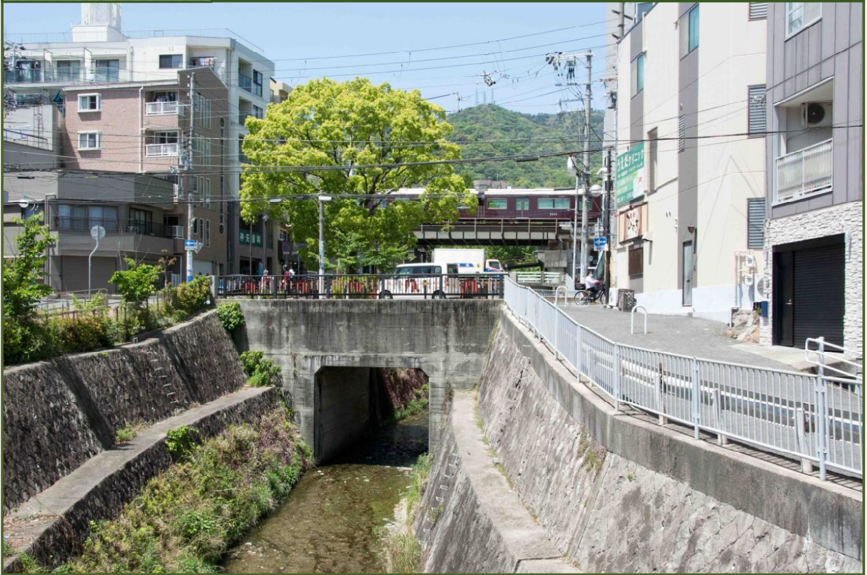
写真-1 上岸地橋から上流を撮影（令和3年4月）
