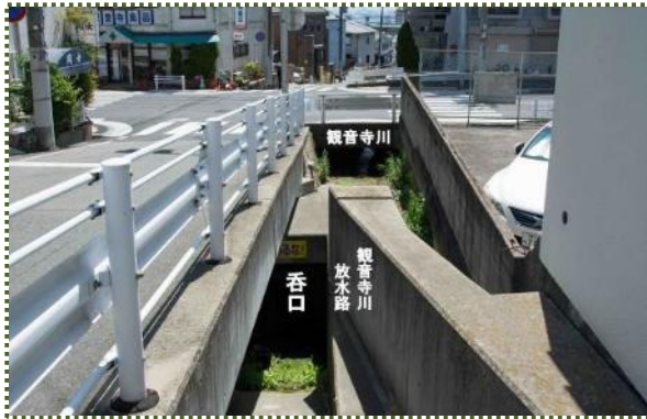
写真-6 観音寺川放水路呑口
