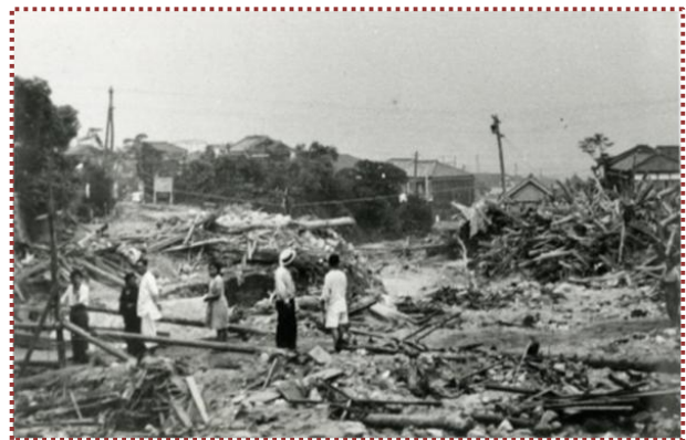
写真-5 灘区中原通王子町付近の被災状況 (阪神大水害デジタルアーカイブから引用)
