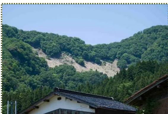
写真-2 牛ヶ峰山の崩落崖
