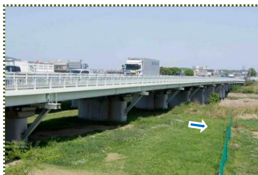
写真-2 国道 171 号・軍行橋
