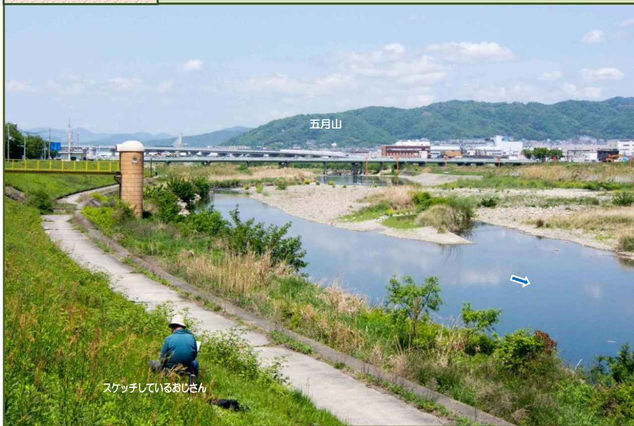
写真-1 猪名川右岸堤防から国道 171 号・軍行橋を望む（令和 4 年 4 月）
