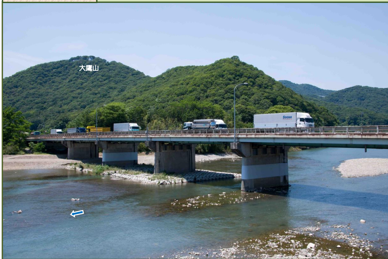
写真-1 国道2号・有年橋（令和3年6月撮影）
