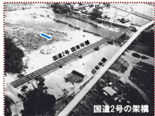
写真-5 国道2号・有年橋の架橋
