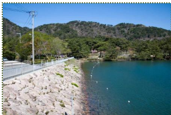
写真-2 奥池（洪水吐付近から撮影）
