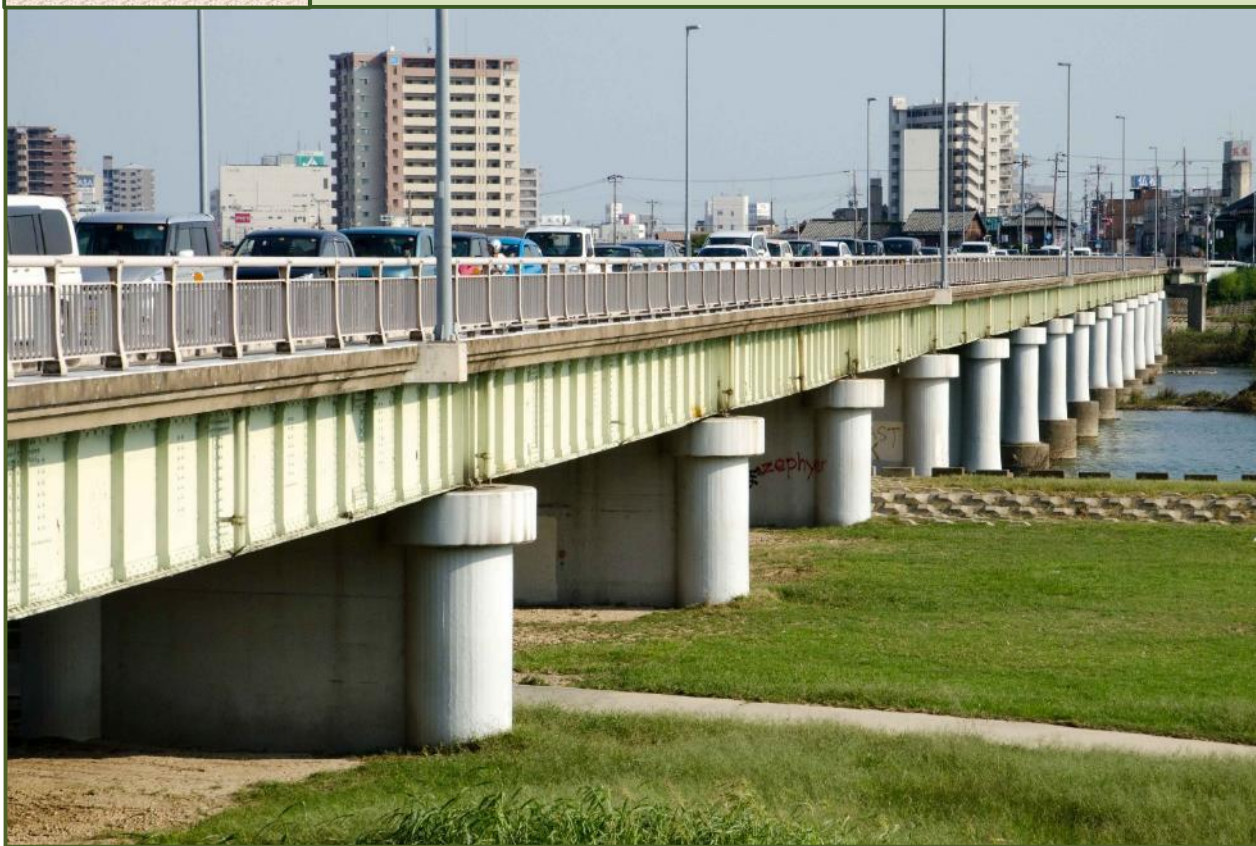
写真-1 加古川に架かる国道2号・加古川橋（平成25年9月撮影）
