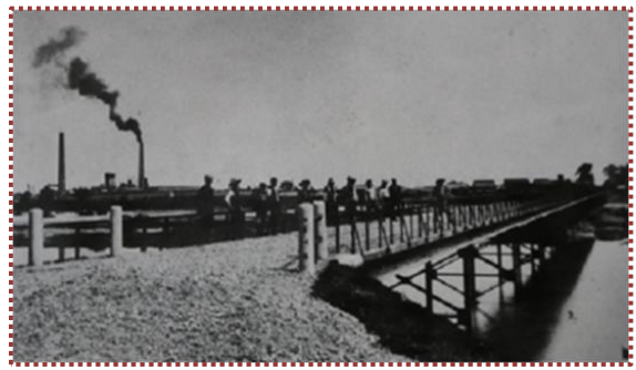
写真-6 旧加古川橋
