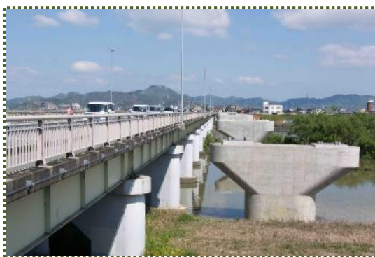
写真-2 加古川橋架け替え工事（令和5年4月撮影）
