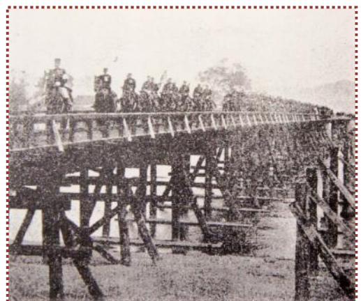
写真-4 明治時代の加古川橋（『失われた風景を歩く』から引用）
