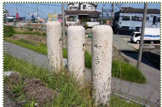
写真-7 旧加古川橋の親柱（令和5年4月撮影）
