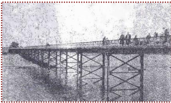
写真-5 旧加古川橋（『道路の改良 第6巻第9号』から引用）
