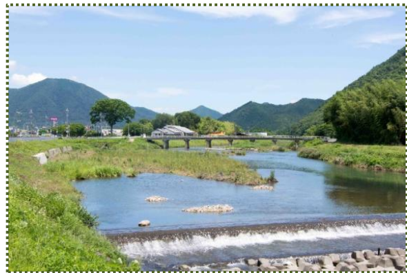
写真-6 杉原川に架かる森本中央大橋付近から森本橋を望む（多可町）
