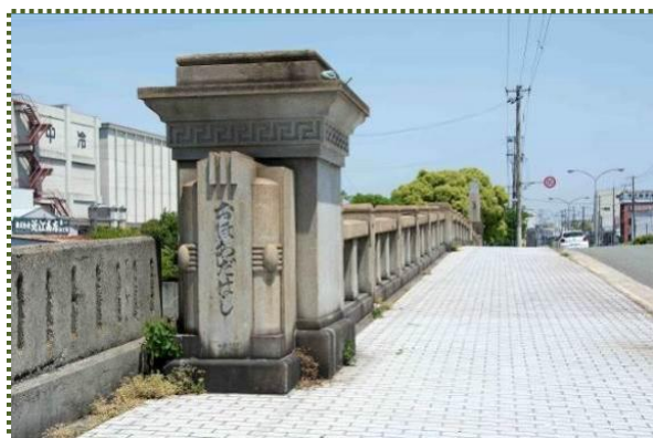
写真-2 大輪田橋北西側の親柱（「おほわたはし」と刻まれている）
