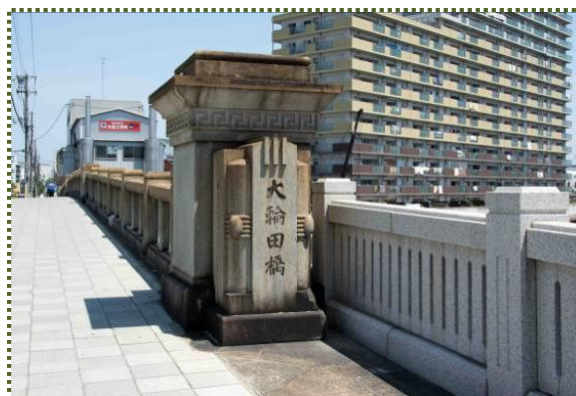
写真-3 大輪田橋南西側の親柱（側面には「大正十三年六月竣工」とある）
