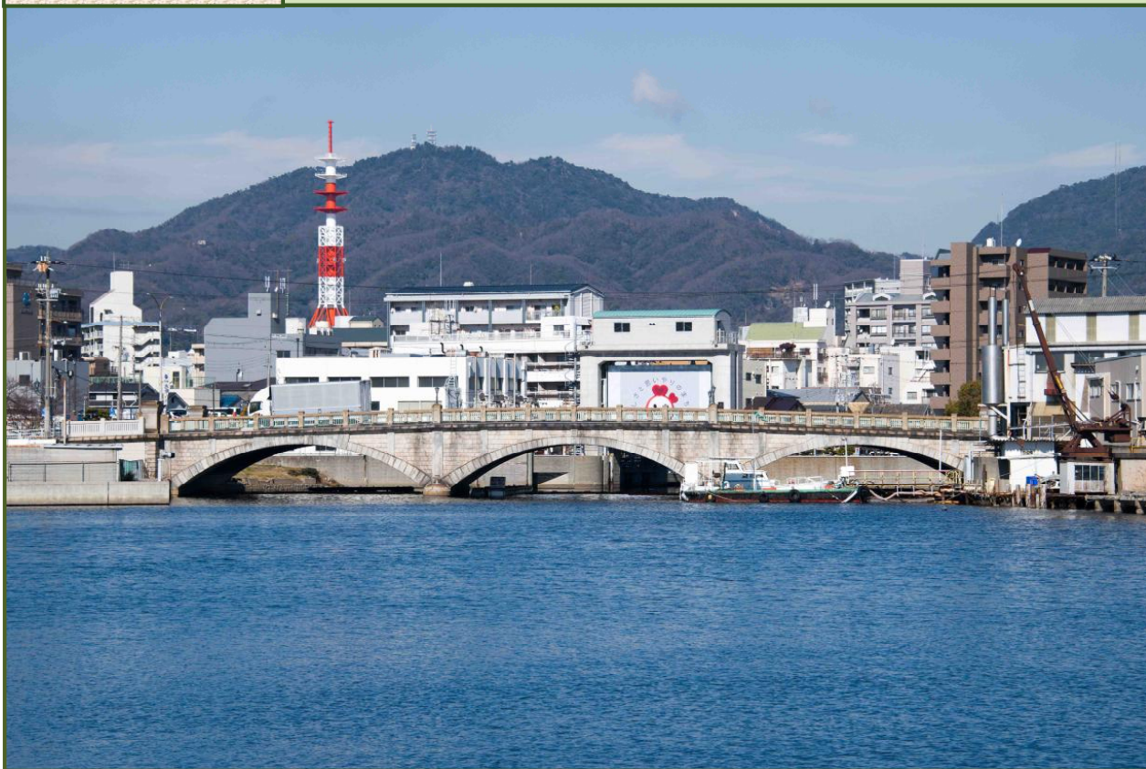
写真-1 新川運河に架かる大輪田橋を撮影（令和5年1月）
