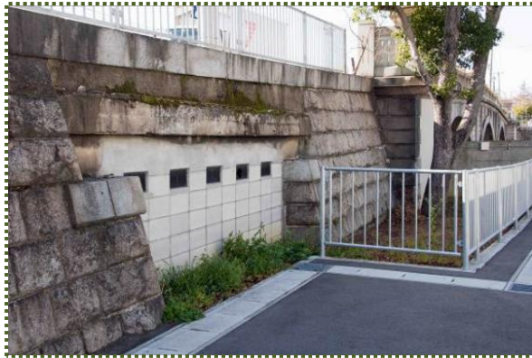
写真-7 橋下通路跡
