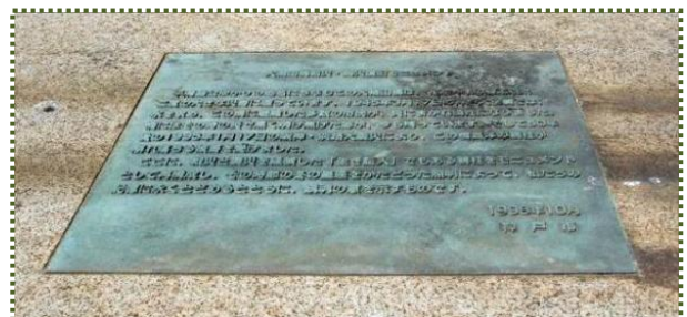
写真-11 親柱上面に埋め込まれた銘板
