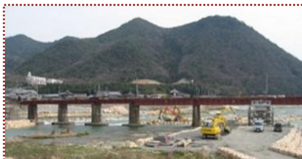
写真-6 加古川線・旧第三加古川橋梁 （『北播磨ローカルネットワーク』HPから引用）
