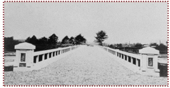
写真-7 旧重春橋（西脇市HP「ふるさと探訪」から引用）
