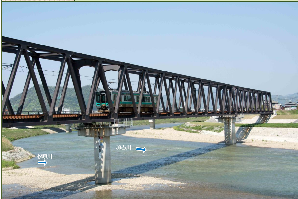
写真-1 加古川右岸堤防から JR 加古川線・第三加古川橋梁を撮影（平成27年4月）
