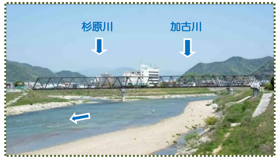
写真-9 第三加古川橋梁
