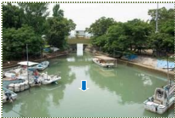
写真-6 新両浜橋から撮影
