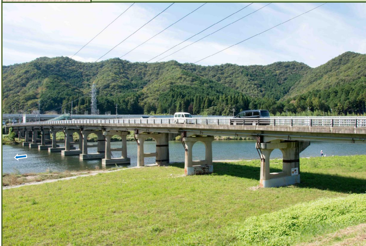
写真-1 畑瀬大橋を加古川左岸から撮影（平成29年5月）
