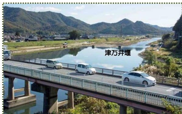
写真-2 畑瀬大橋と下流に見える津万井堰（令和元年11月撮影）
