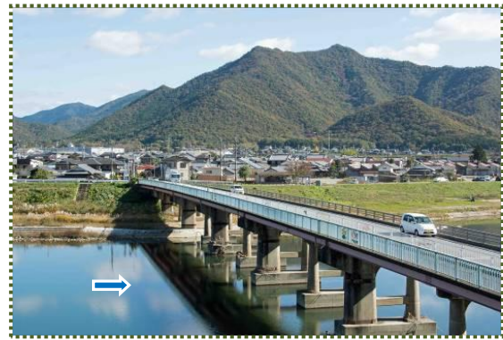
写真-11 畑瀬大橋西詰の歩道橋から撮影 (令和元年 11 月)
