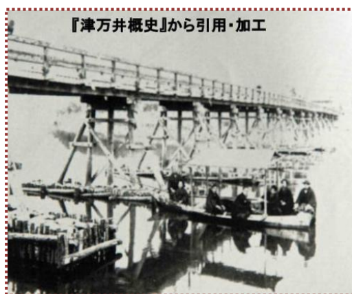
写真-8 完成した畑瀬大橋と完成を祝う渡し舟
