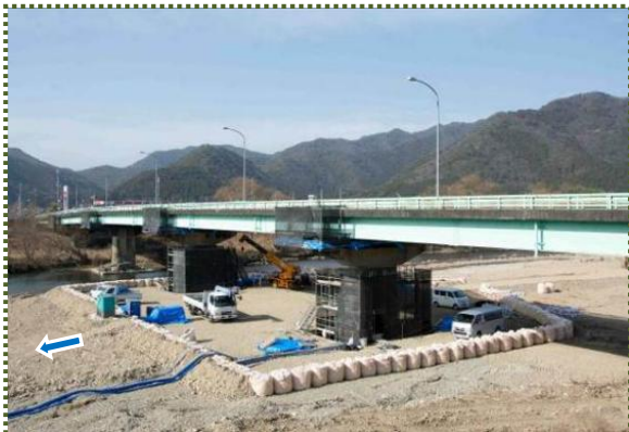
写真-13 耐震補強工事中の中央橋（令和3年1月撮影）
