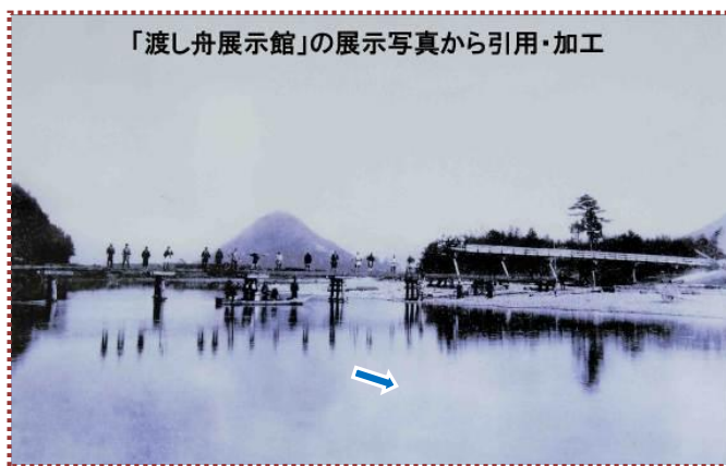
写真-9 中央部流失後の畑瀬木橋と完成した仮橋、復活した渡し舟
