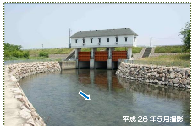
写真-7 蟠洞川樋門（堤外側）
