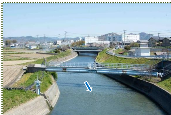
写真-6 蟠洞川（揖保川堤防上から撮影）
