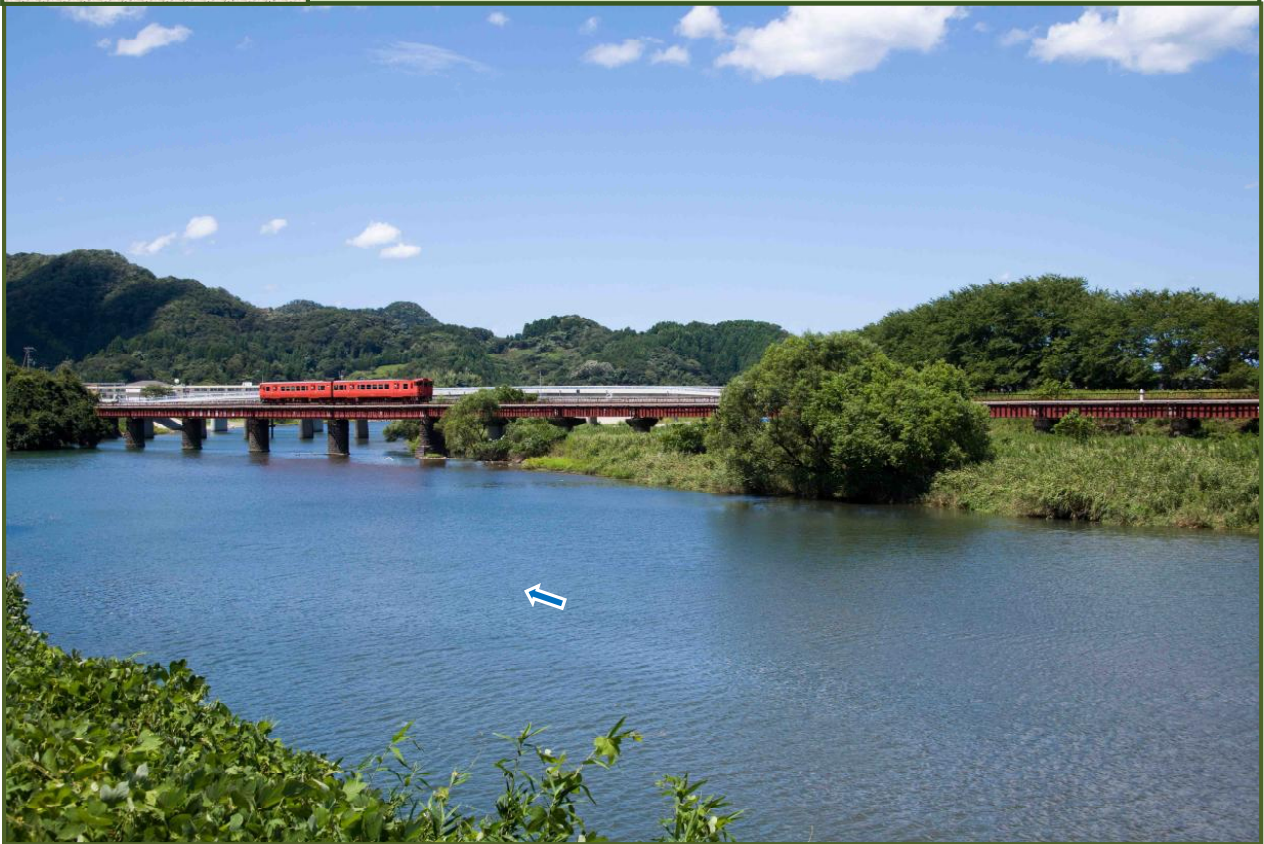
写真-1 矢田川に架かる JR 山陰本線・矢田川橋梁（令和5年8月撮影）
