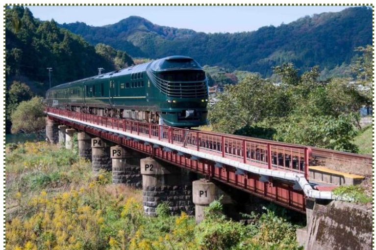
写真-7 矢田川右岸堤防から矢田川橋梁を撮影（P1～4 の橋脚）
