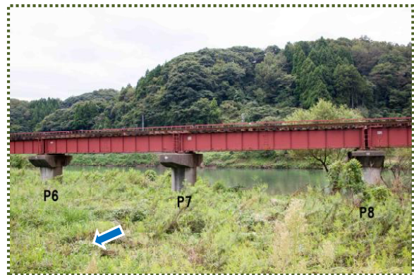
写真-6 P6～8 のコンクリート製 T 型橋脚
