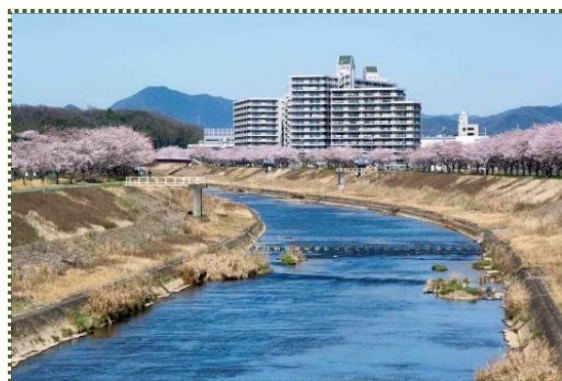
写真-2 川除上橋から上流を撮影
