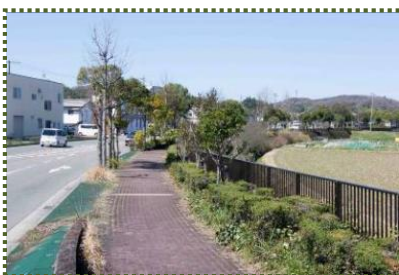
写真-5 松山堤（黒石三田線の歩道部）
