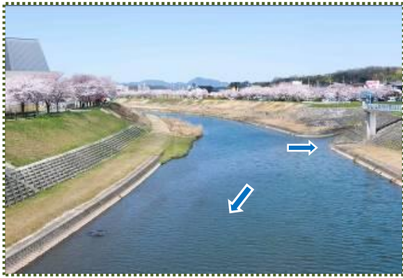
写真-3 松山用水取水施設（ポンプアップ）
