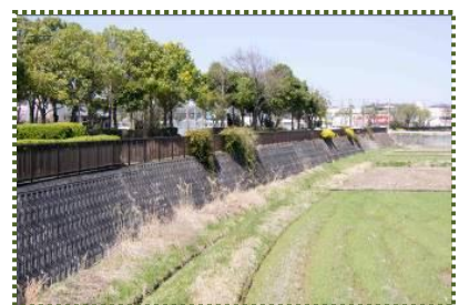
写真-7 松山堤（松山堤交差点より南）
