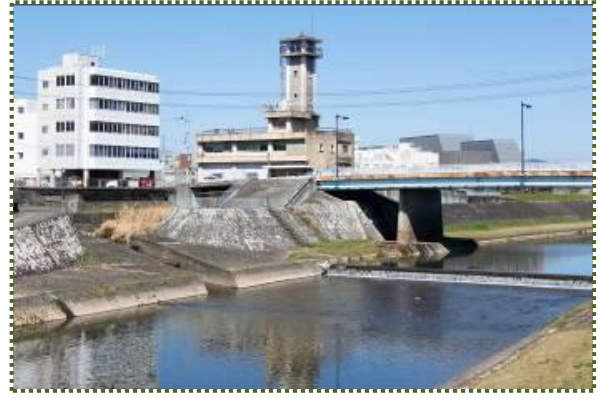
写真-4 三田大橋直下の取水施設（ラバーダム）
