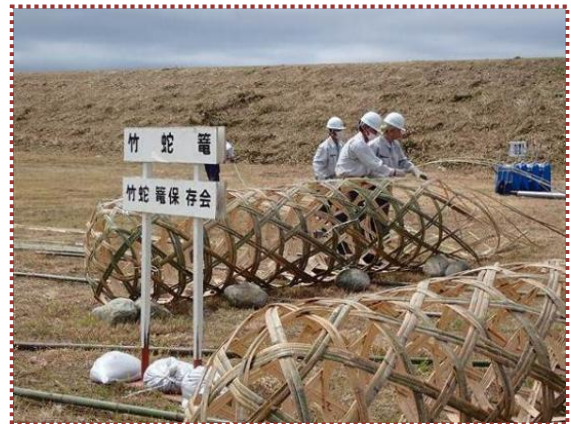
写真-3 黒部川水防工法研修会での竹蛇籠製作風景
