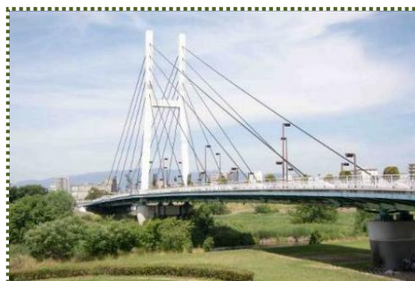
写真-2 神津大橋
