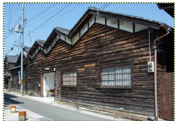
写真-7 木造の織物工場を改装・再生した「播州織工房館」
