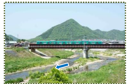
写真-11 野間川に架かる JR 板波川線橋梁
