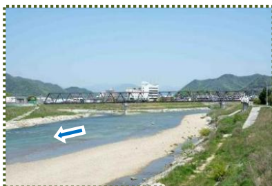
写真-9 杉原川合流点に架かる JR 加古川線橋梁
