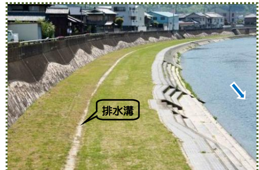
写真-8 杉原川の高水敷に設けられた染色排水用の排水溝
