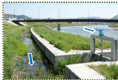
写真-10 地下水位維持のために設けられた堤外水路
