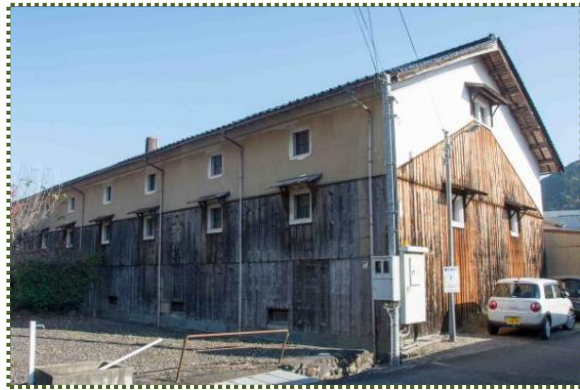
写真-8 仕込蔵の山側の面
