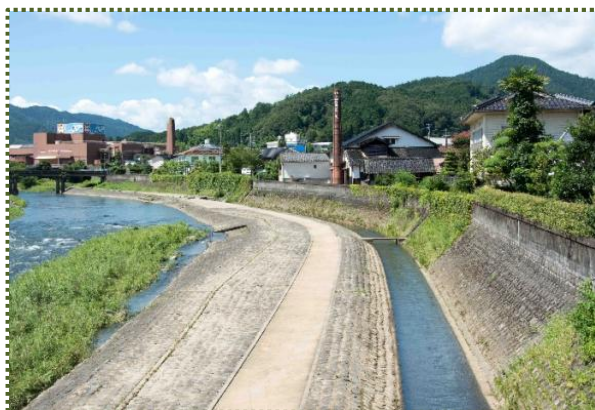
写真-2 護岸沿いの堤外水路（平成27年8月撮影）
