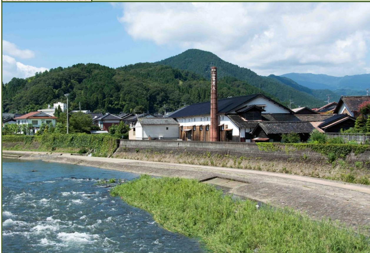
写真-1 八木川に架かる仲町歩道橋から撮影（平成27年8月）
