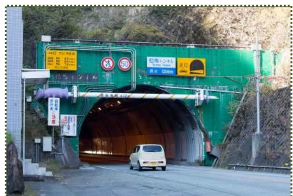
写真-12 但馬トンネル (高さ制限バーはストックの形)
