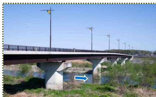
写真-2 新大河橋
