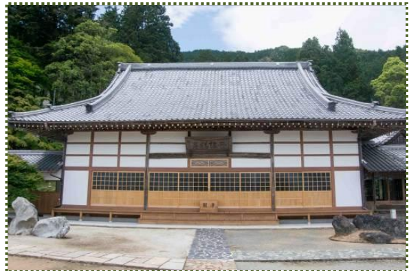
写真-7 復旧後の石像寺本堂
