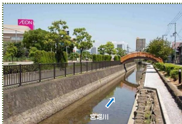
写真-2 末広橋から下流を撮影（前方の橋は了覺寺橋） 左の建物はイオンモール姫路リバーシティ
