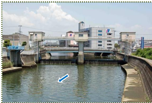
写真-6 船場川潮止堰（堰上流左岸側に宮堀川樋門）
