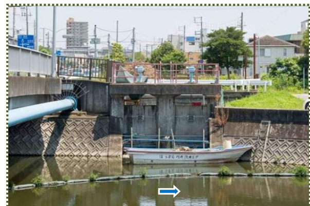
写真-7 宮堀川樋門
