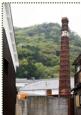
写真-3 カネ中醤油の煙突
