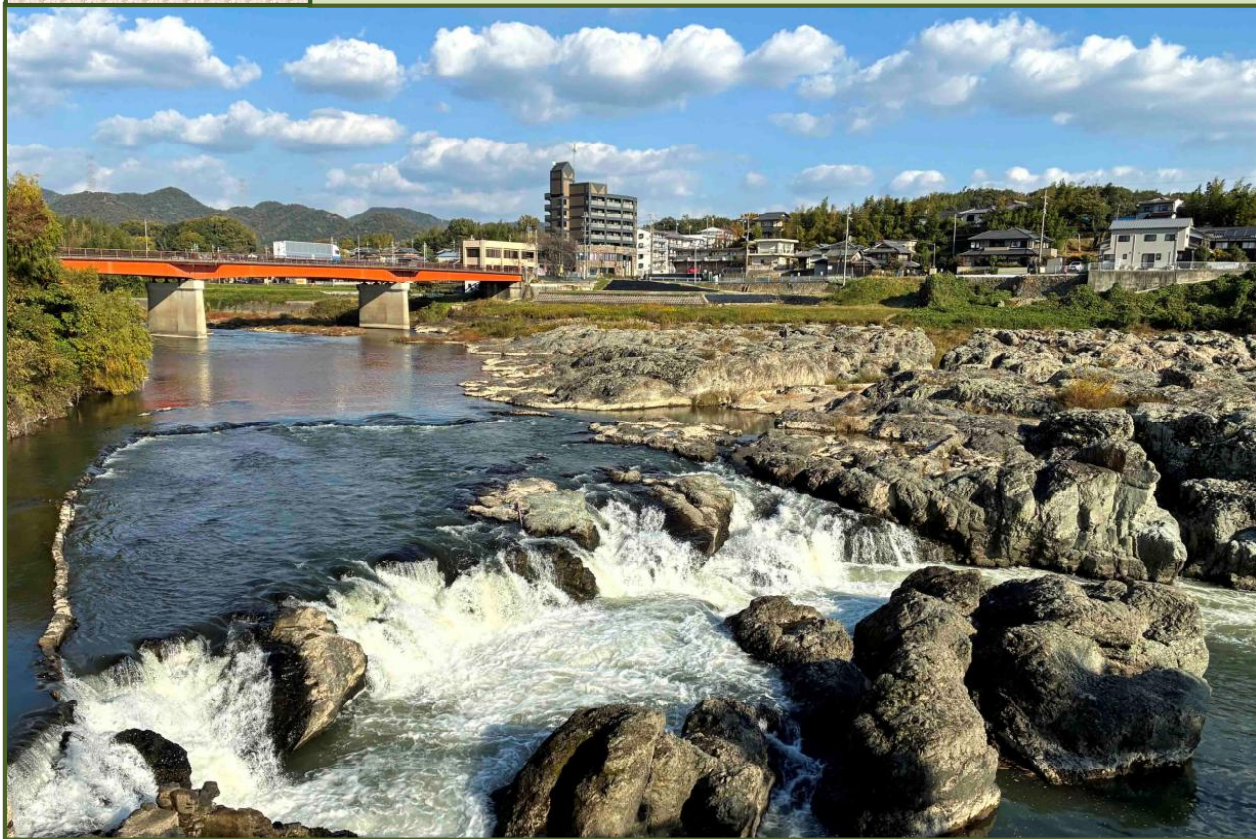
写真-1 「闘龍すくえあから闘龍灘を撮影（令和7年11月）」
