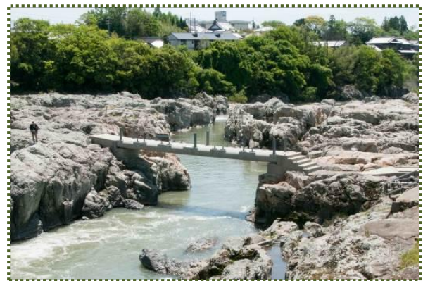
写真-6 闘龍灘に架けられた錦雲橋
