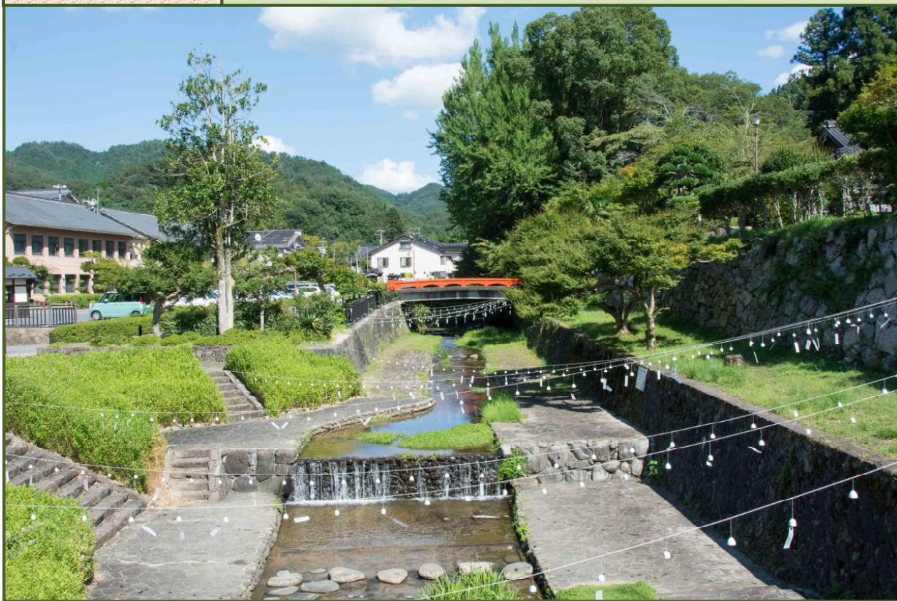
写真-1 谷山川に吊るされた風鈴が涼やかな音色を響かせる（平成27年8月撮影）
