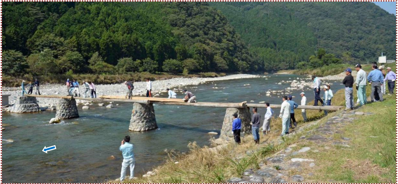
写真-14 流れ橋かけ直しの状況
