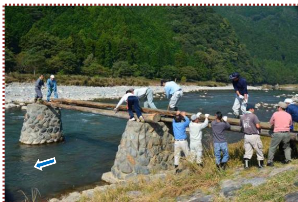
写真-10 ㊦ 2本の丸太を利用して橋板の架設
