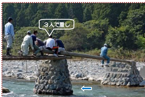
写真-5 ③ 1 本目の丸太の架設・一人目が渡る
