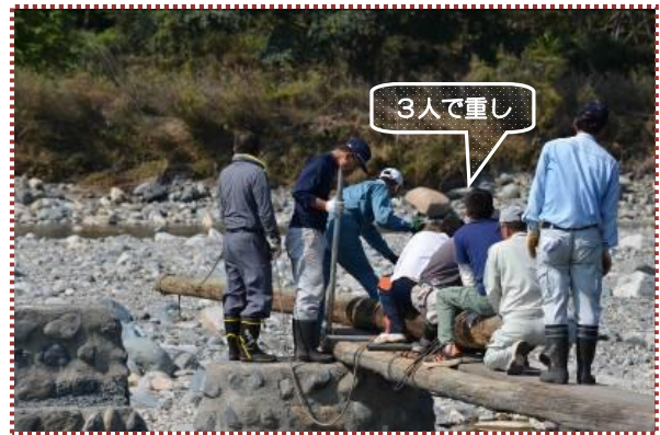
写真-4 ② 鉄パイプ2本の上に載せた1本目の丸太をスライドさせる
