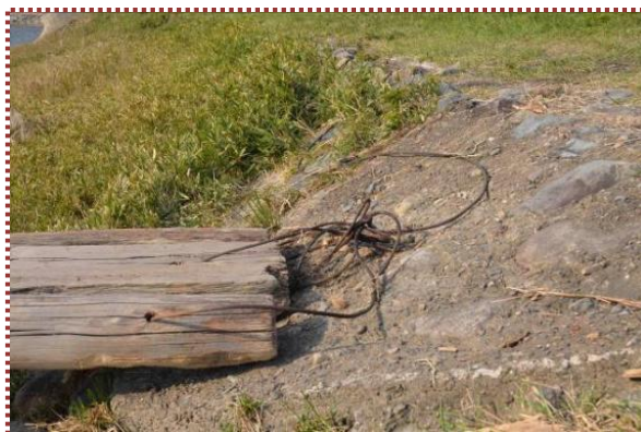
写真-12 護岸天端に打ち込まれたアンカーに繋がれたワイヤー
