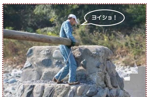
写真-6 ④ 1 本目の丸太を橋脚の上に設置する
