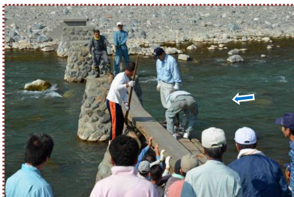
写真-9 ㊦ 第1スパン上をスライドさせながら橋板を架設
