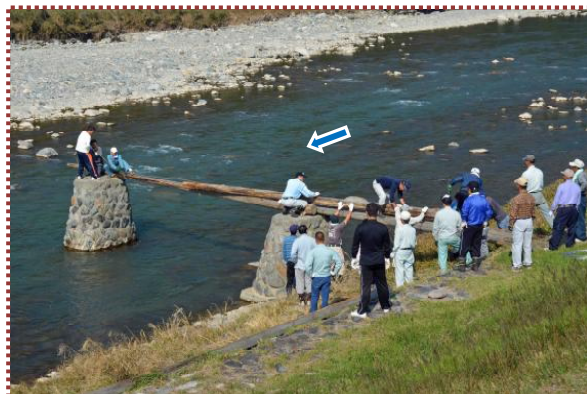
写真-8 ㊦ 1本目の丸太を利用して2本目の丸太を架設
