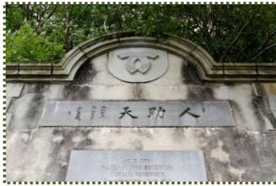
写真-7 堰堤右岸部にある「扁額」
