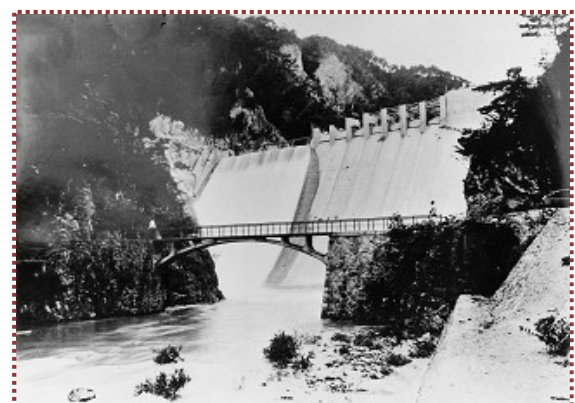
写真-2 嵩上げ工事中の千苅堰堤 (神戸市水道局 HP から引用)
