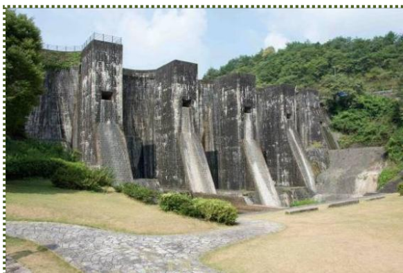
写真-5 我が国初のマルチプルアーチダム・豊稔池堰堤
