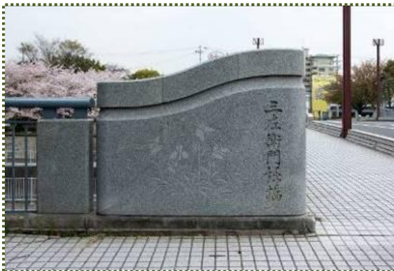
写真-7 三左衛門堀橋の親柱
