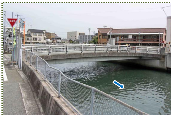
写真-2 野田川に架かる向島橋（橋の左岸側が向島）
