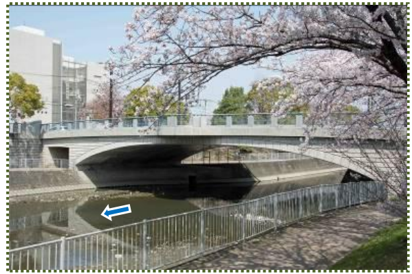
写真-6 三左衛門堀橋
