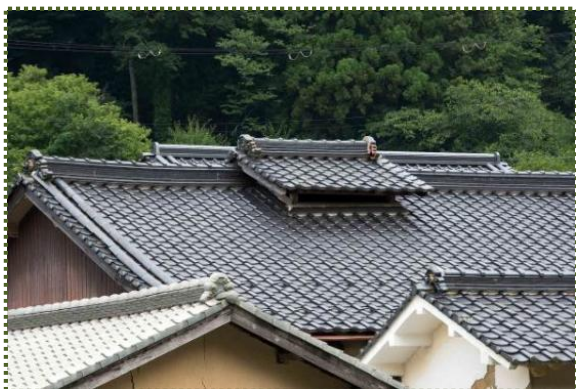
写真-11 越屋根のある民家
