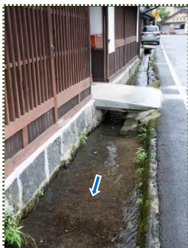
写真-5 北新町を流れる上水路
