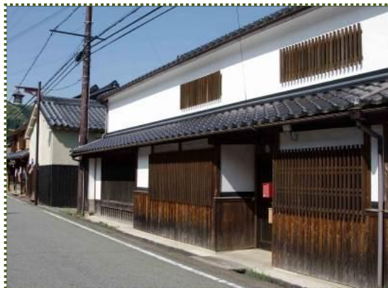
写真-15 修復後の町家
