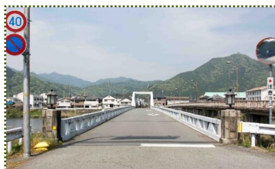
写真-3 屋形橋（左岸側から撮影）
