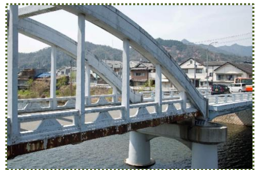
写真-7 屋形橋のアーチ部
