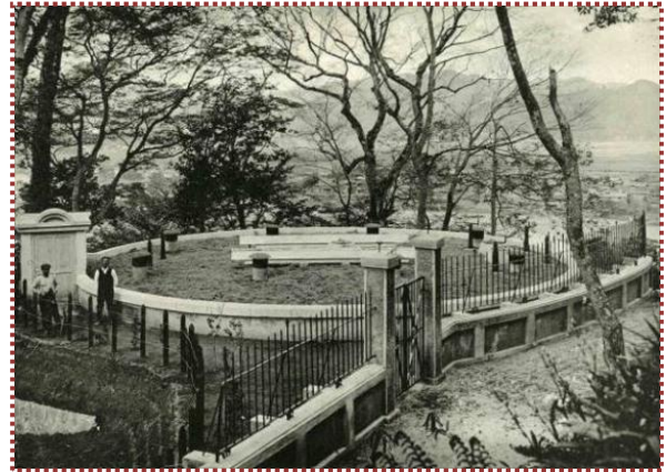
写真-6 神武山配水池（豊岡市提供）
