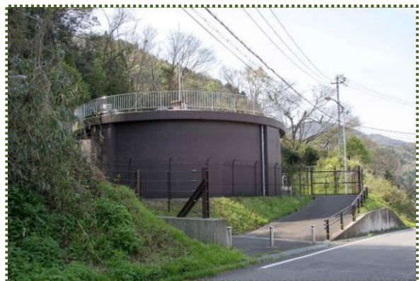
写真-10 二見水源地近くの二見配水池
