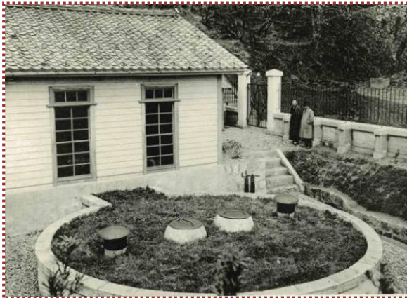
写真-5 神武山麓のポンプ場（豊岡市提供）
