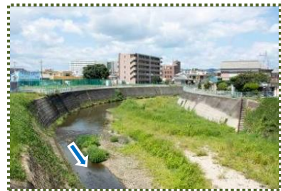
写真-9 御着南橋から上流を望む
