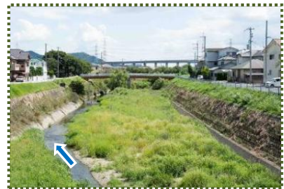
写真-10 御着南橋から下流を望む
