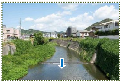
写真-8 国道2号・御着橋から上流を望む
