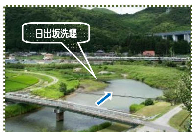
写真-15 武庫川・日出坂洗堰の上流部
