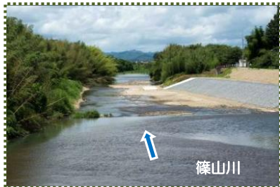
写真-6 泉橋から下流を望む
