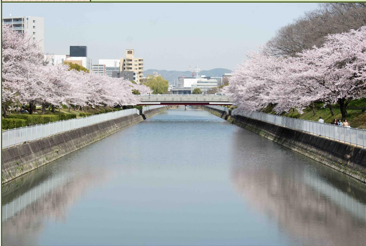
写真-1 庄田橋から上流を撮影（平成30年3月）
