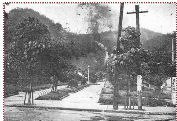
写真-6 7月11日午後5時20分 暗渠天井部爆破の瞬間 （『神戸市水害誌・附図』から引用）
