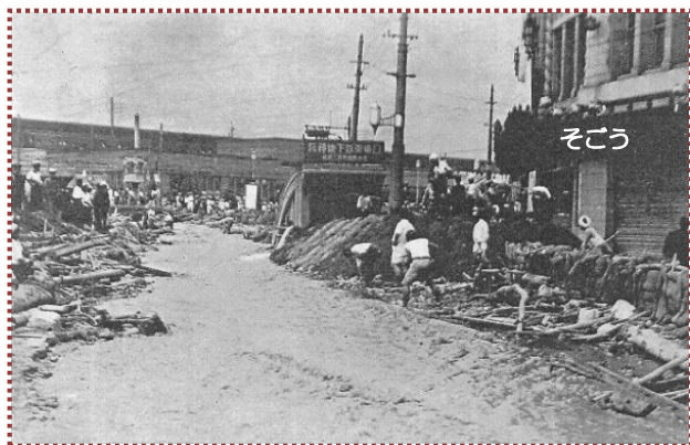
写真-11 国際道路の復旧作業（7/8） （『神戸市水害誌』から引用・加工）
