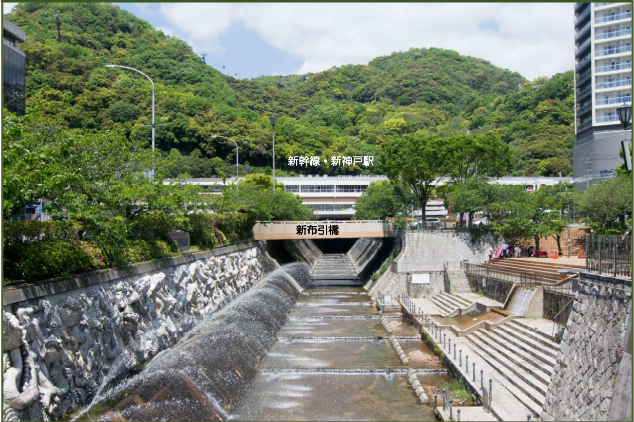
写真-1 布引橋から新神戸駅を撮影（平成 29 年 5 月）
