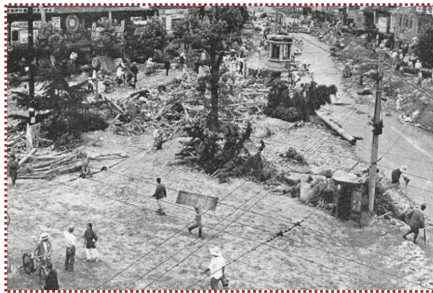
写真-7 加納町交差点での復旧作業 (7/8) (『神戸市水害誌』から引用)
