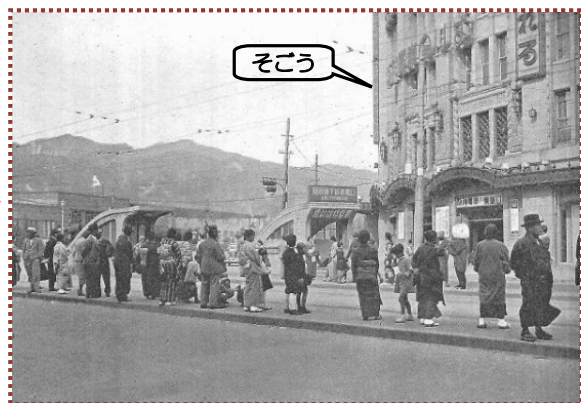
写真-12 復旧後の国際道路（10/8） （『神戸市水害誌』から引用・加工）
