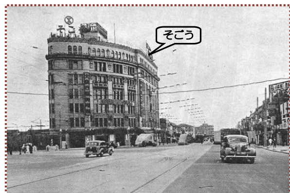
写真-10 復旧後の国際道路 (10/8) (『神戸市水害誌』から引用)
