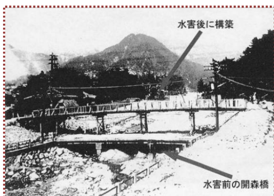
写真-2 阪神大水害後の開森橋付近 （阪神大水害デジタルアーカイブ掲載写真を加工）
