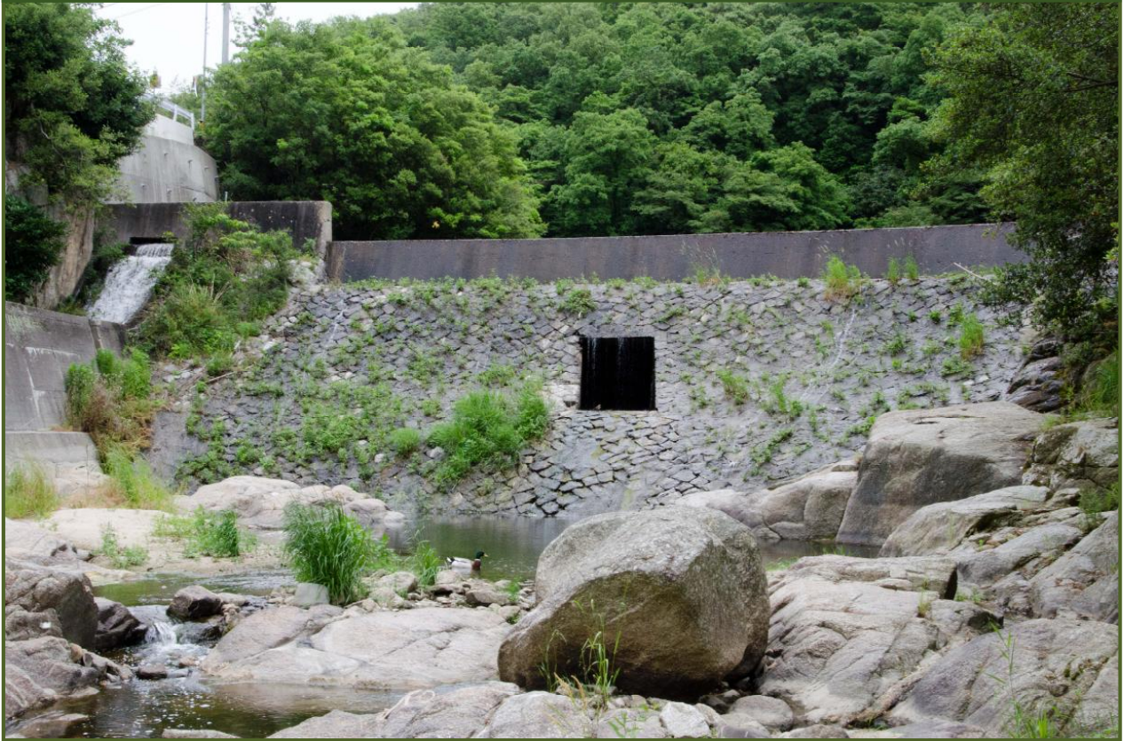
写真-1 川池堰堤（平成25年5月撮影）
