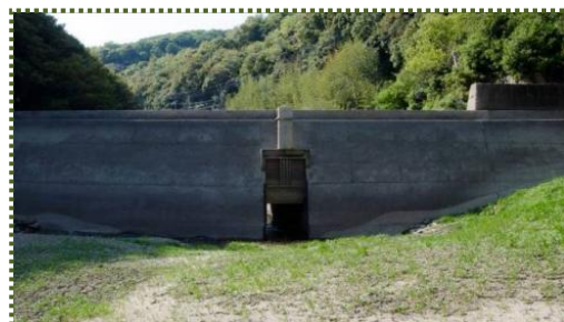
写真-7 川池堰堤の上流面
