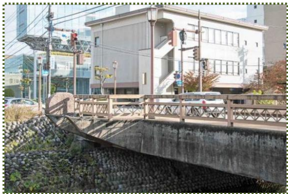
写真-8 松川に架かる舟橋（上流側）
