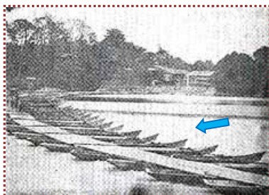
写真-10 越中富山の船橋
