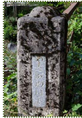
写真-11 右岸側左の親柱
