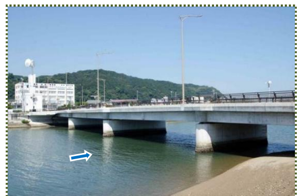
写真-14 現在の洲本橋
