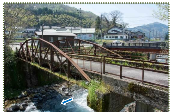
写真-9 県道橋直下流に架かる矢田川橋（町道橋）
