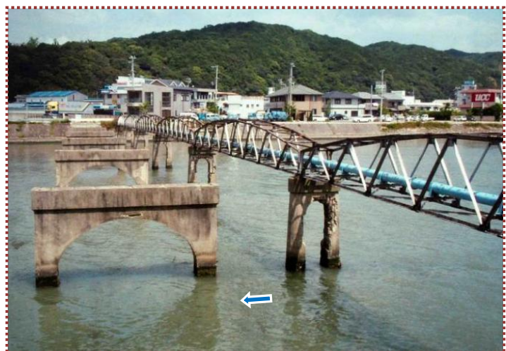
写真-18 塩屋橋の橋脚 (平成 16 年頃撮影) 隣は昭和初期完成の水管橋
