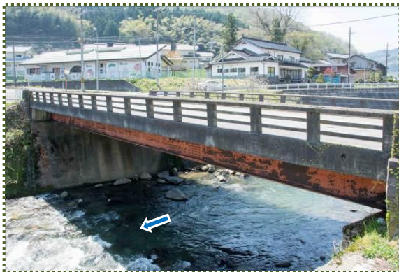
写真-8 矢田川橋（県道橋）
