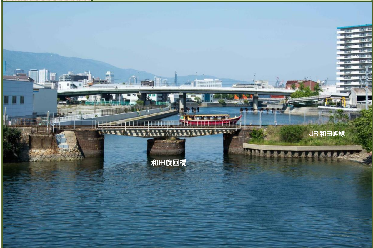
写真-1 材木橋から兵庫運河および JR 和田岬線の和田旋回橋を撮影（平成26年5月）
