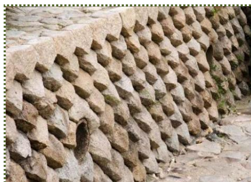
写真-5 逆瀬川の鎧積堰堤
