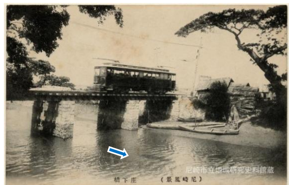
写真-6 庄下川橋梁を渡る阪神電車（明治末～大正期に撮影） （尼崎市立地域研究史料館提供写真を加工）
