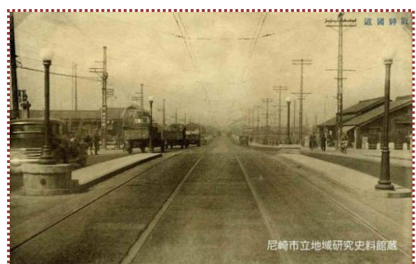
写真-8 昭和 9 年頃の阪神国道・玉江橋付近 （尼崎市立地域研究史料館提供写真を加工）
