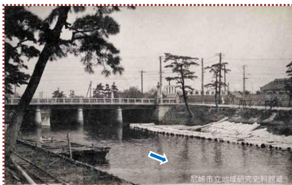
写真-7 庄下川に架かる玉江橋（昭和 4 年頃） （尼崎市立地域研究史料館提供写真を加工）
