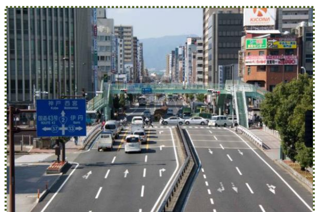
写真-10 国道 2 号・玉江橋（平成 27 年 10 月撮影）
