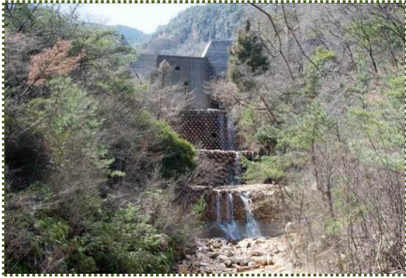
写真-10 四段堰堤
