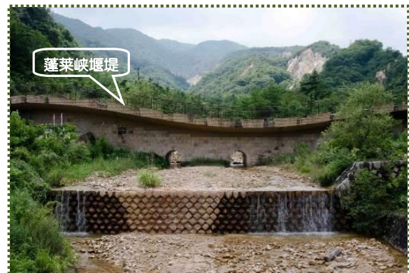
写真-6 下流から蓬莱峡堰堤を撮影
