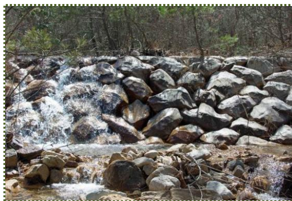
写真-4 自然石積堰堤
