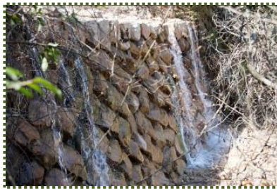
写真-13 まだ大丈夫です！ 2 段目鎧積堰堤
