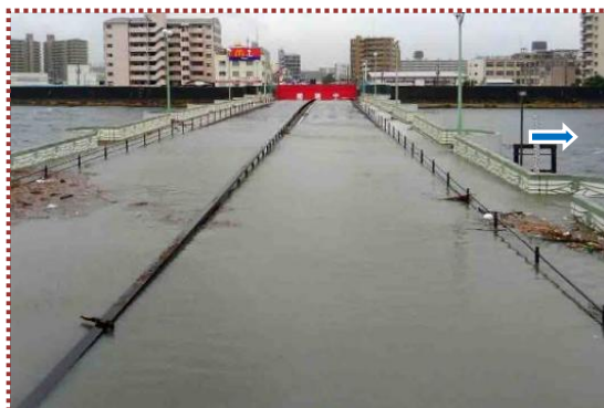
写真-9 左門橋上の湛水状況（尼崎側から大阪側を望む）
