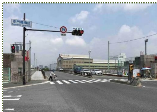
写真-7 国道 2 号・左門橋（大阪側から尼崎方向を撮影）
