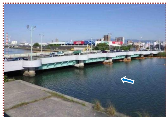
写真-6 現在の左門橋（左門橋補強工事 Twitter から引用）
