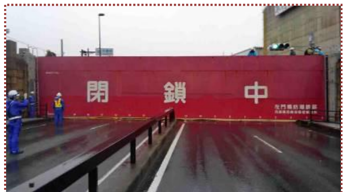
写真-8 閉鎖中の防潮鉄扉
