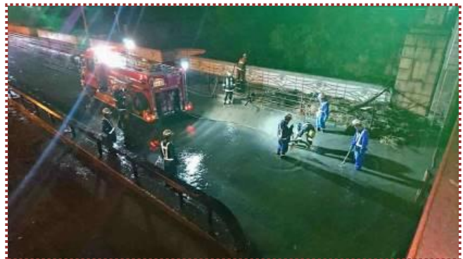
写真-10 消防車による夜間の排水作業
