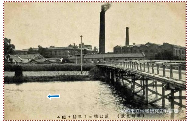
写真-3 辰巳橋と尼崎紡績工場（尼崎市立地域研究史料館提供）
