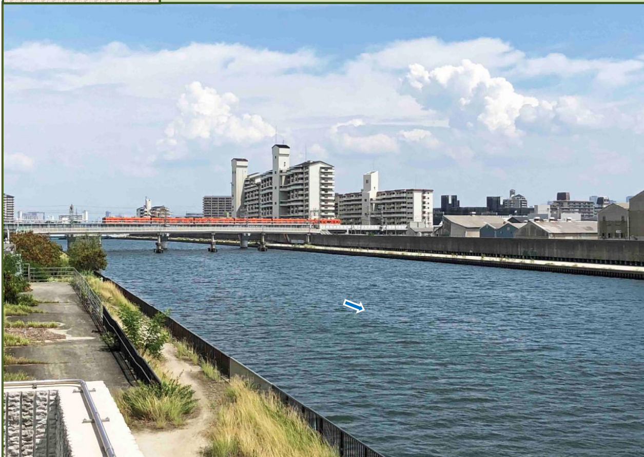
写真-1 左門殿川右岸堤防から阪神電鉄本線を撮影（令和元年8月）
