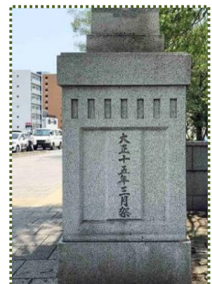
写真-7 右岸下流側の親柱
