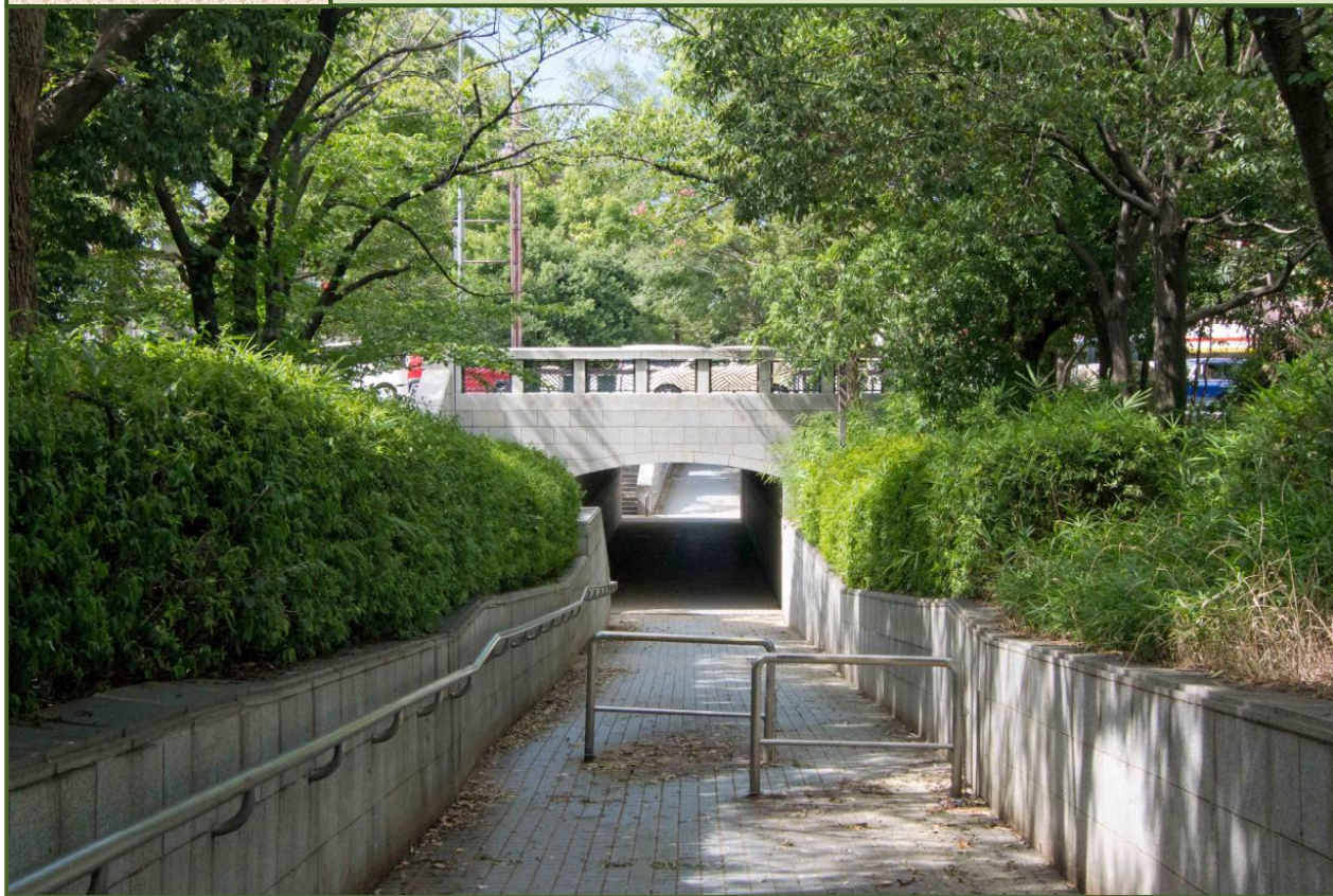
写真-1 国道2号・稲川橋（令和元年8月撮影）
