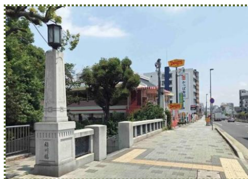
写真-2 国道2号・稲川橋
