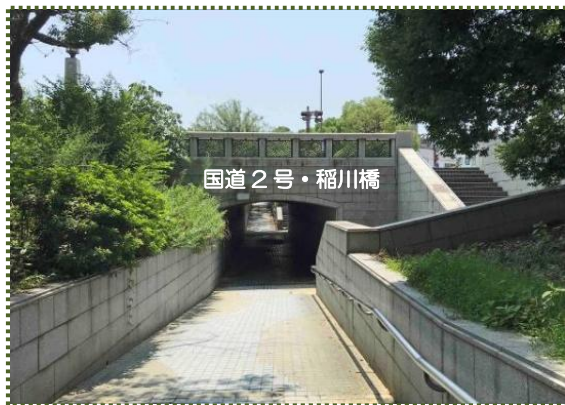
写真-5 北側から稲川橋を撮影
