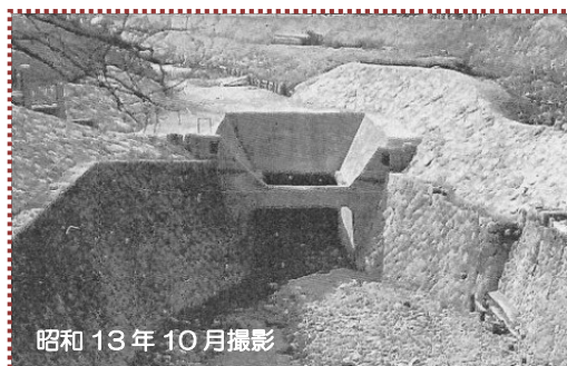
写真-3 暗渠入口部（『神戸市水害誌』から引用・加工）
